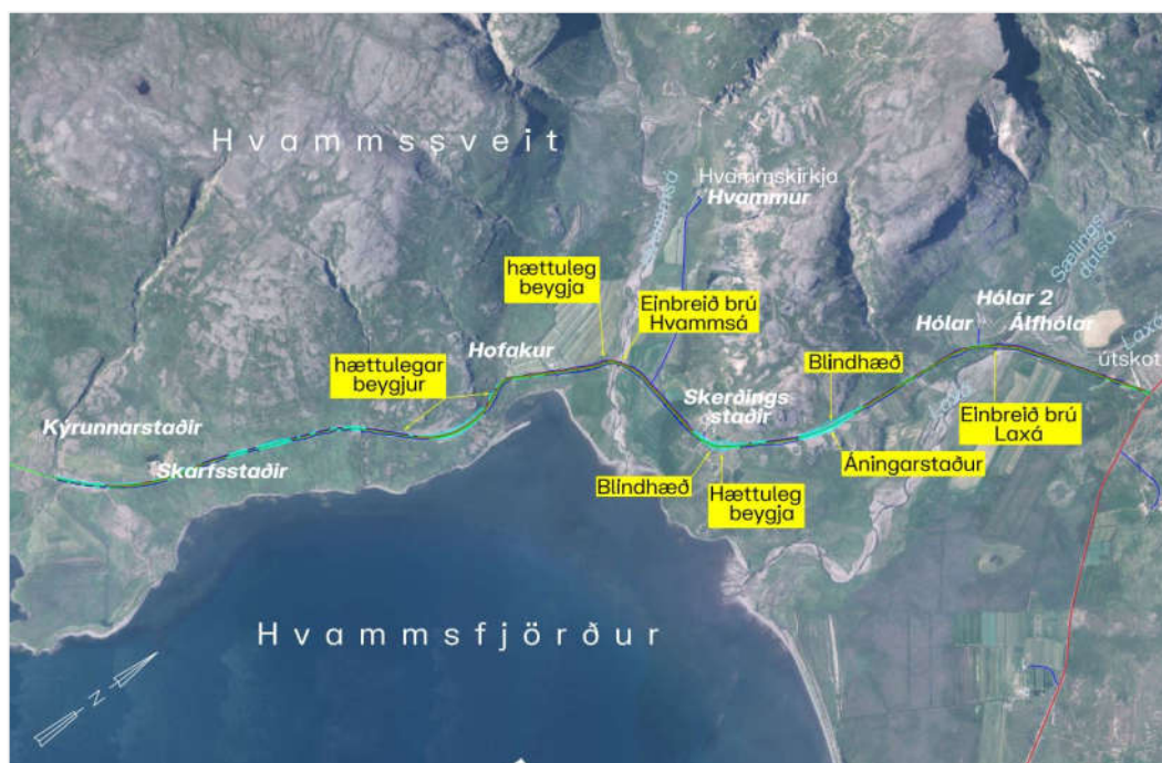
↑ Mynd 2.6. Varhugaverðir staðir á núverandi Klofningsvegi á fyrirhuguðu framkvæmdasvæði.
