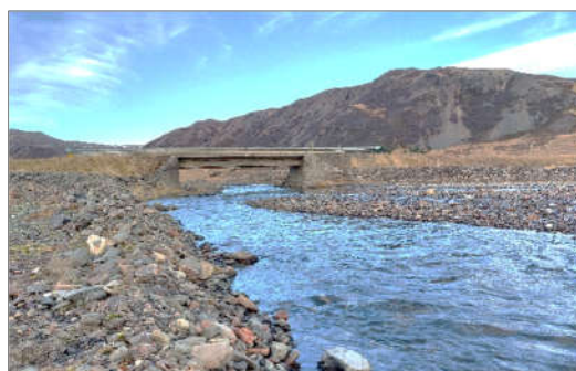
↑ Mynd 2.8. Núverandi brú á Hvammsá. Horft til norðvesturs.
